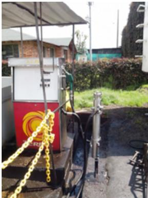
**Figura No. 6** – Depurador magnético multi-etapa y con trampa de agua
