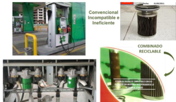
**Figura No. 5** – Ecofiltros en dispensador de combustible en EDS
